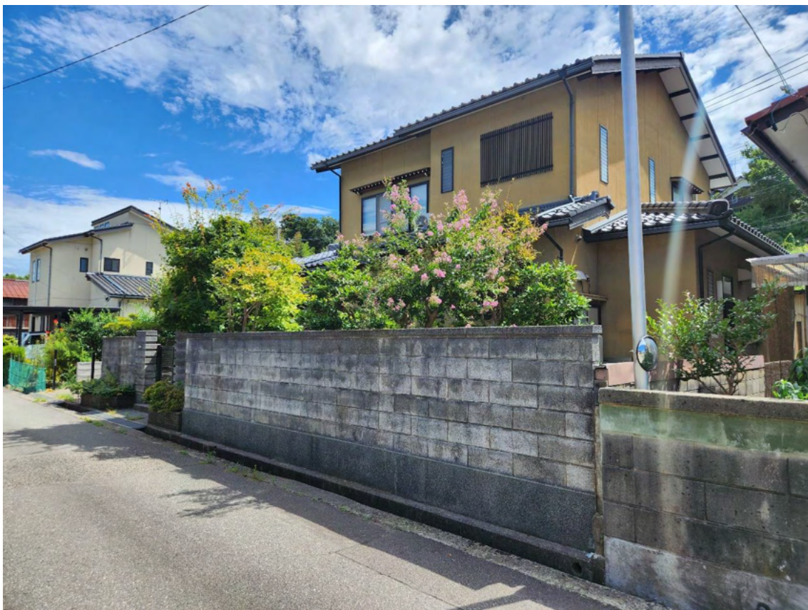
北西方向より撮影
