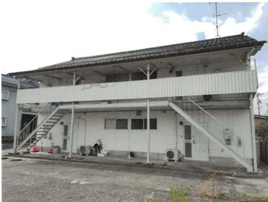
北東方より撮影
